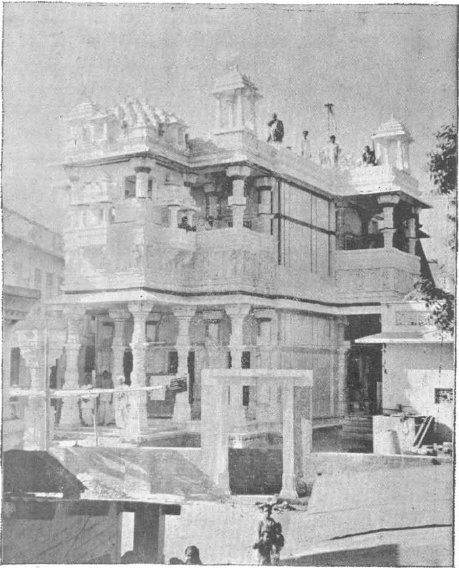
અમદાવાદ-સાબરમતી-એ ભૂમિયુક્ત જૈન પાશ્વનાથ આસાદ (અધ્યાય ૧૧) (Constructing Architect P. O. Sompura)
