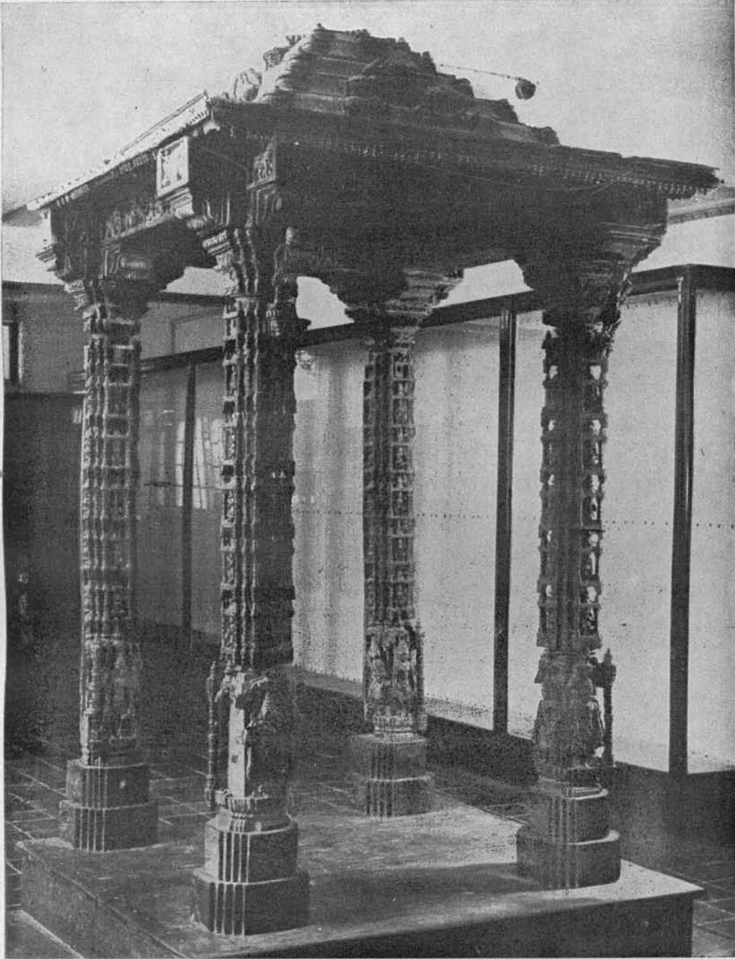
गुजरात : काण्ठ-निर्मित मण्डप
